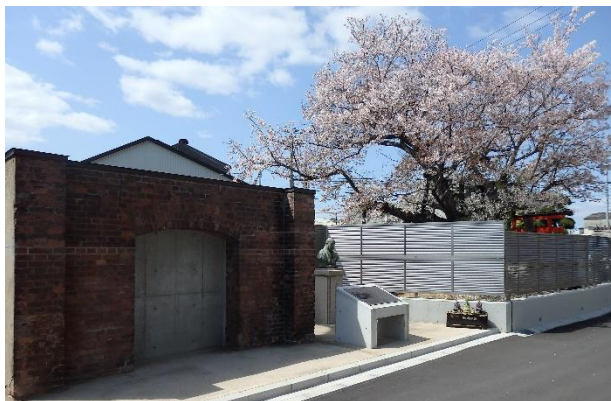
(飾磨津物揚場跡レンガ造建物モニュメント)
