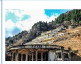
12 神子畑選鉱場跡 明延鉱山の鉱石を選別する施設であった。山の斜面を利用した機械選鉱場は、かつて規模・産出量とともに「東洋一」と謳われた。
