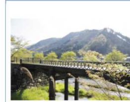
11 神子畑鉄橋・羽瀬鉄橋 生野と神子畑鉱山を結ぶ鉄橋。神子畑鉄橋は、全鉄製の橋梁としては日本最古。
