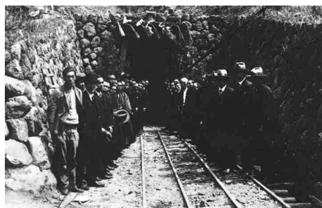
明神第三隧道貫通記念写真(昭和4年)
