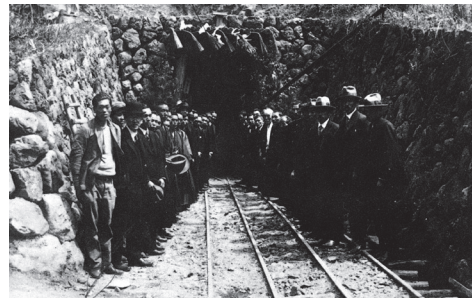
明神第三隧道貫通記念写真(昭和4年)
