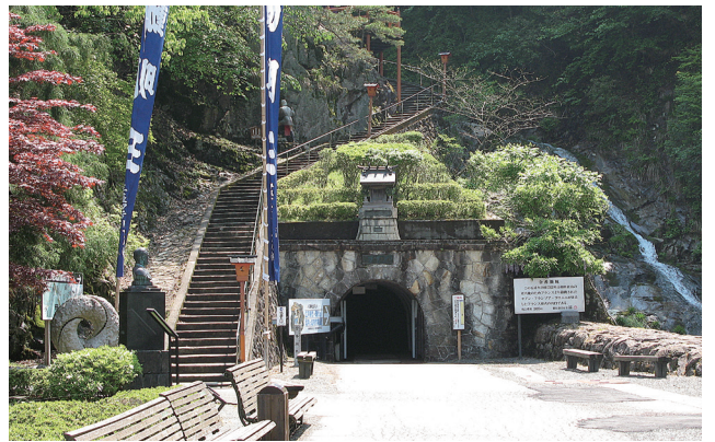
石組みで築造された観光坑道入口(金香瀨坑口)
