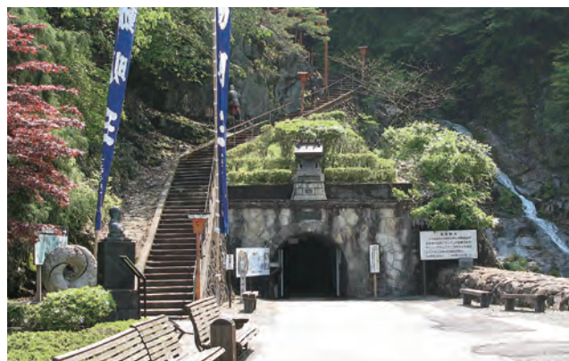
石組みで築造された観光坑道入口(金香瀬坑口)
