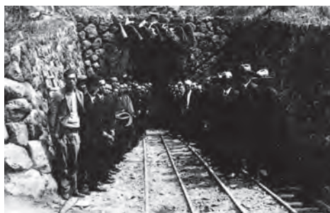
明神第三隧道貫通記念写真(昭和4年)
